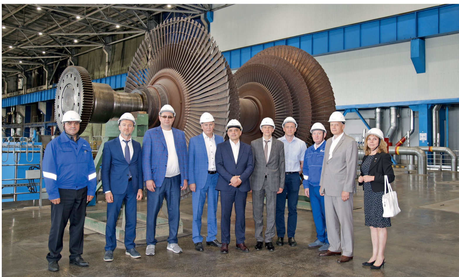
В машинном зале ТЭЦ-22
